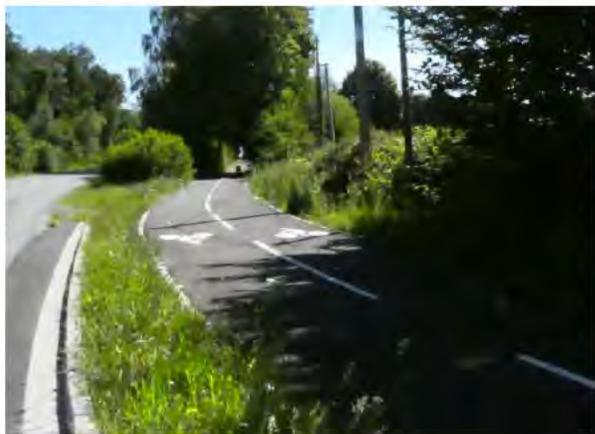
Chaussée **réservée aux cycles** et physiquement séparée de la circulation motorisée. De 100 k€ / km à 700 k€ / km
