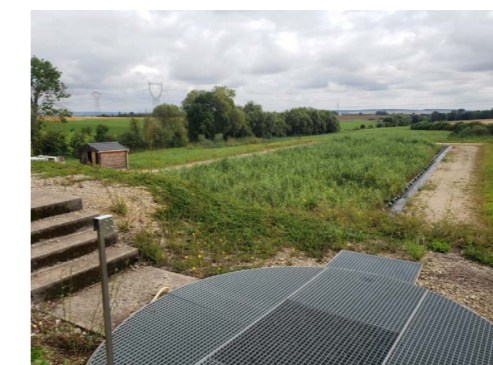
Station d'épuration de Tantonville
