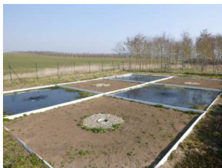
Station d'épuration de Saint-Firmin
