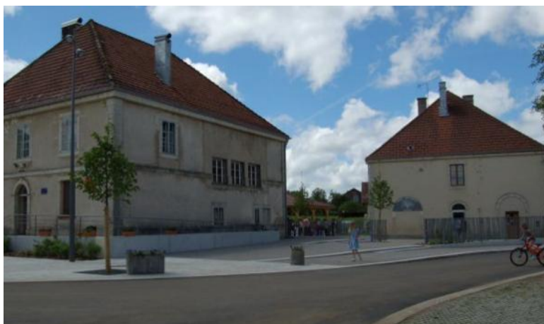
Aménagement d'un carrefour avec le partage de la voirie, Mont-de-Laval (25)
