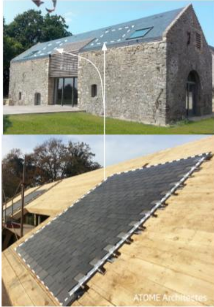
Rénovation d'un bâtiment agricole intégrant des panneaux chauffe-eau solaires à la toiture ardoise - Source : ATOME Architecte
