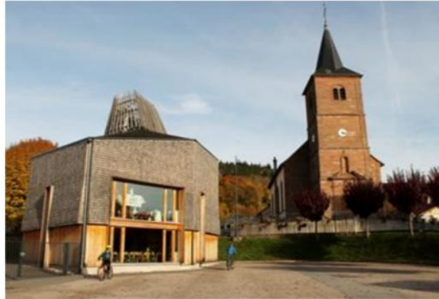
Bâtiment périscolaire à Tendon (88) utilisant des matériaux locaux et biosourcés (bois, paille...)
