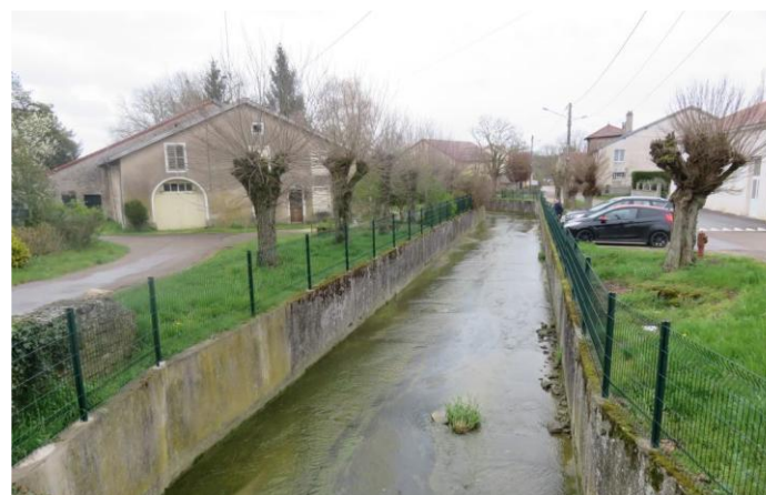
Ruisseau canalisé à renaturer (source : Even conseil)
